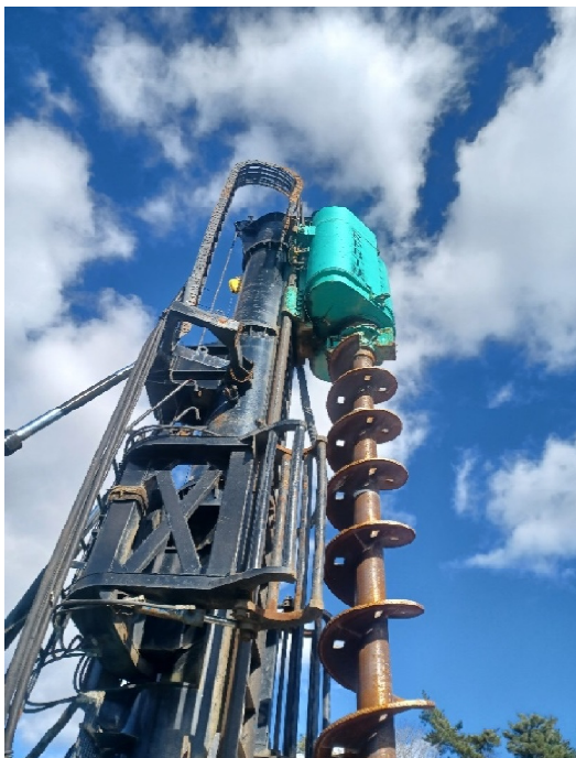
2023年12月 「杭打ち立ち会い」
