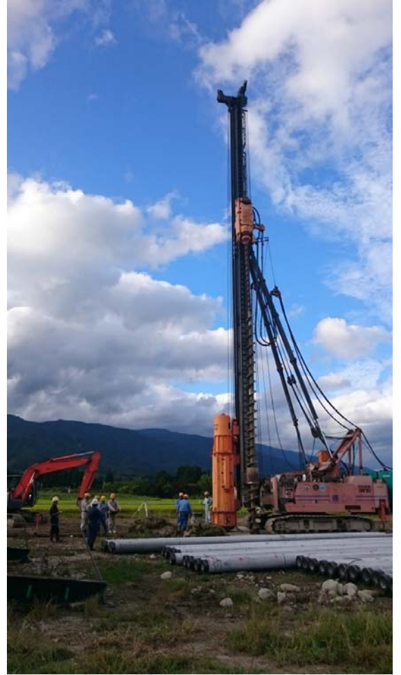
2016年9月 「生打ち杭現場」
