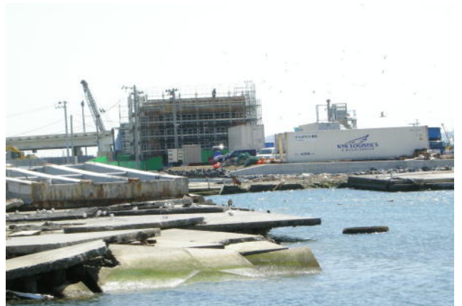
2012年6月 「女川に建築中の現場」
